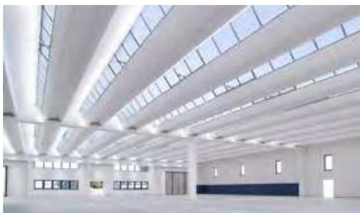
Capannone con luce naturale: regolazione automatica dell'intensità luminosa delle lampade LED.
